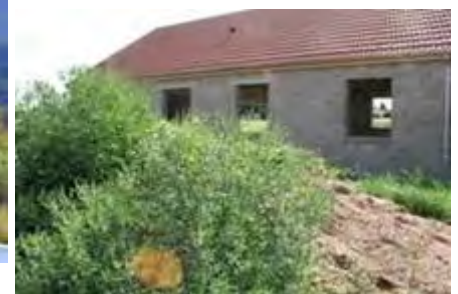
Chantier de construction
